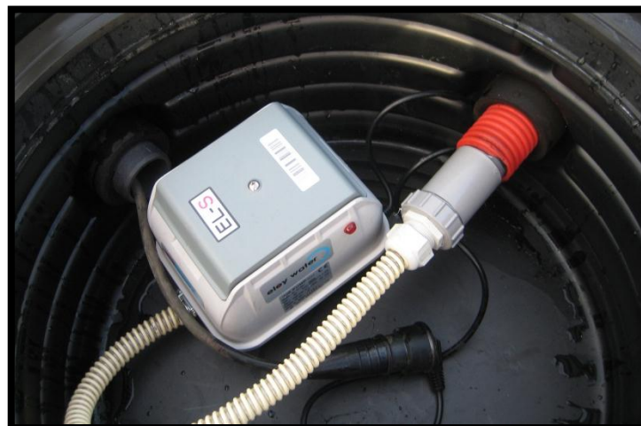
Figure 7-9: Raccordement électrique en bâtiment pour l'Oxyfix 5EH
